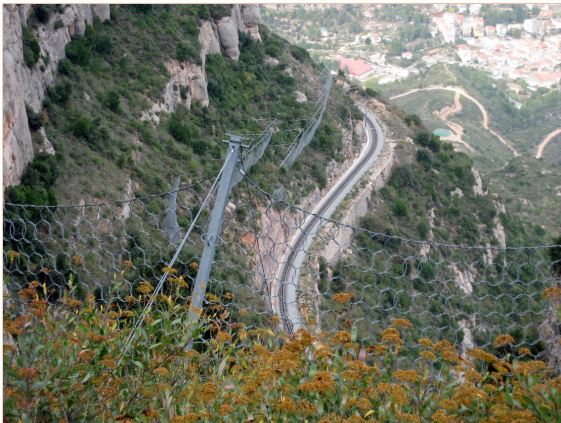
Blick auf die Geleise der Zahnradbahn, die vom Tal zum Kloster Montserrat führt. Entlang der Strecke sind fast durchgehend Hochenergie-Steinschlagnetze errichtet.
