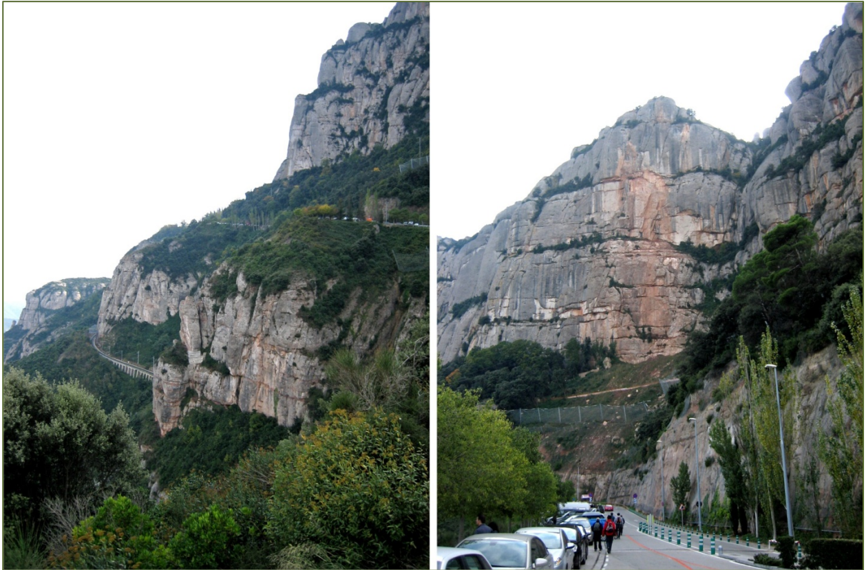
Steinschlagsicherungsmaßnahmen entlang der Verkehrswege in der Region Montserrat.
